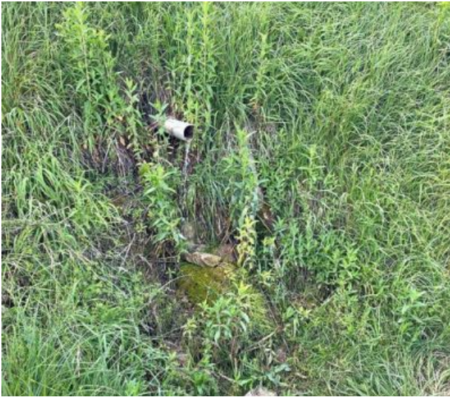
Vorher ein Wasserrohr.
